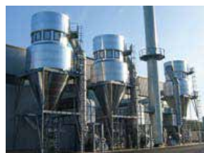
Filtration de la poussière du hangar à machines
